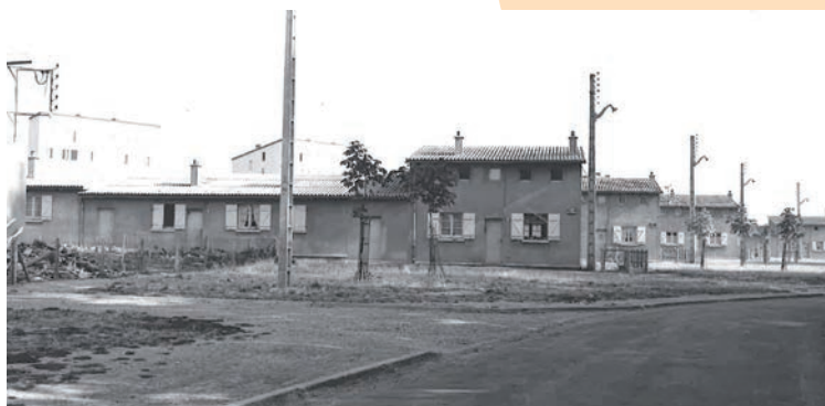
Logements d'urgence rue Constantine.
