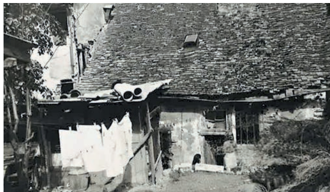
Logement insalubre, rue de la Corroierie en 1946, (archives Chartres Habitat).
