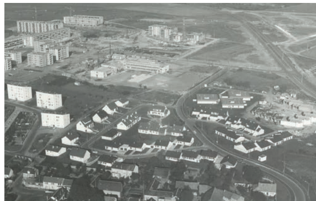
La construction de la Madeleine (Archives municipales de Chartres).
