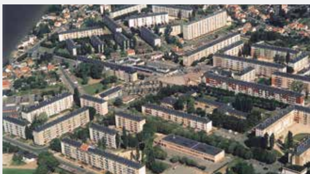
Le quartier de Beaulieu a été construit entre 1960 et 1964. Le coup d'envoi du vaste projet de renouvellement urbain est donné en 2003.
